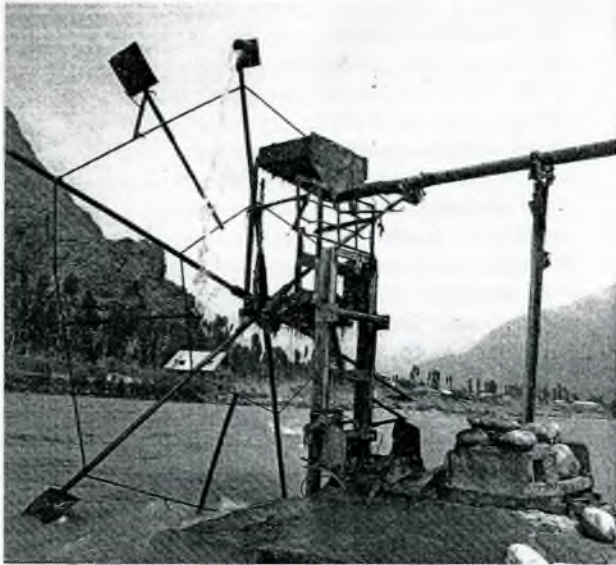
Рис.5. Некоторые водоподъемные механизмы, изобретенные в глубокой древности, используются и сегодня. Среднеазиатский Чигирь.
